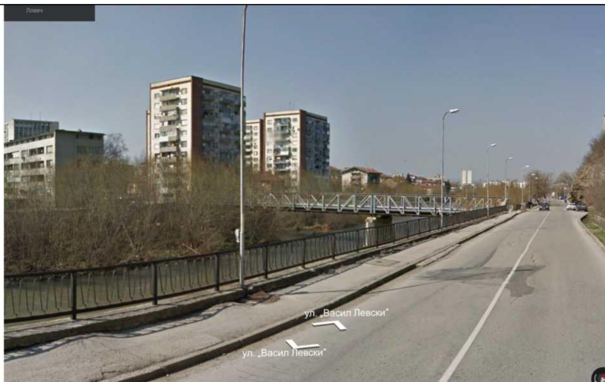
Корекцията на р.Осъм в централната част на гр. Ловеч
